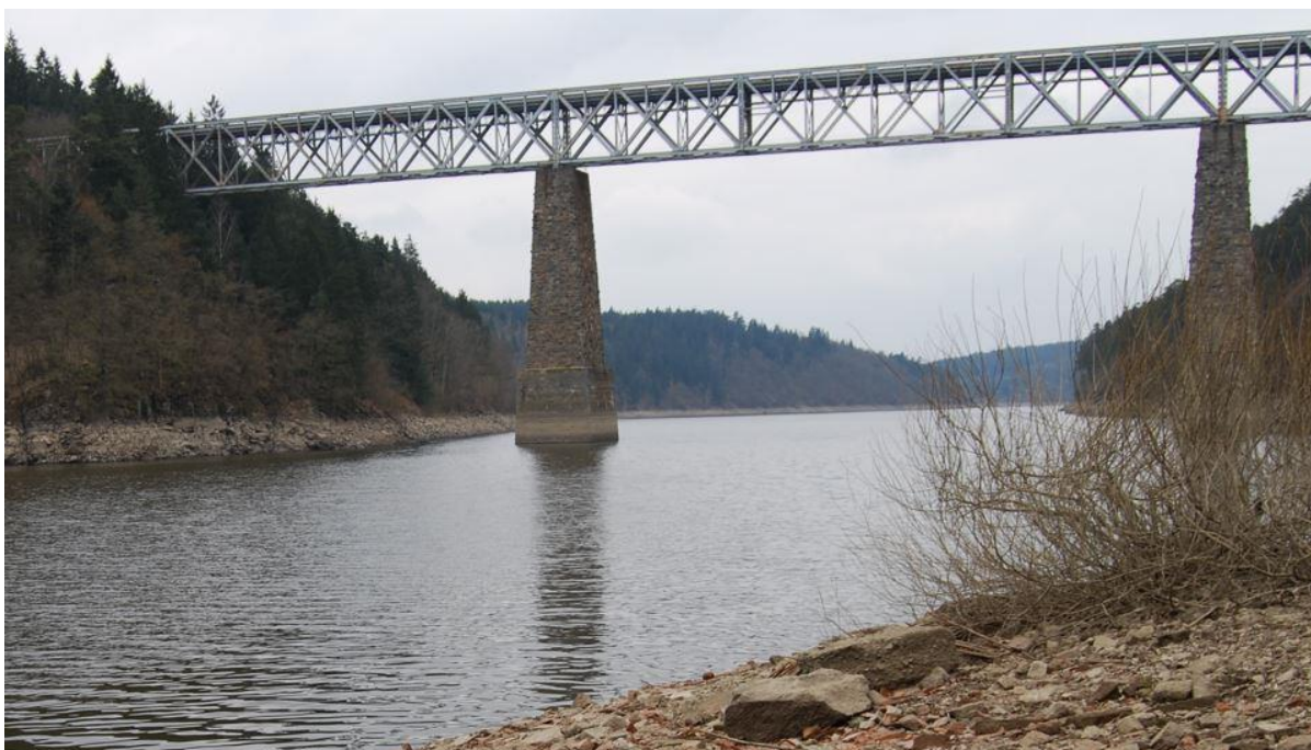
Červenský železniční most, Písek
